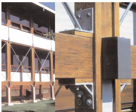
Fig. 6: Edificio per uffici, Vancouver (Canada), Henry Hawthorn, 1993. Vista d'insieme e dettaglio del sistema di attacco pilastri, travi secondarie in Parallam e tiranti di controventamento. Processo di produzione tipo del Parallam: sfogliatura del tronco, essiccazione dei fogli, taglio longitudinale dei fogli, selezione strisce, applicazione del collante, assemblaggio delle strisce, pressaggio a microonde, rifinitura, taglio in senso longitudinale, piallatura, controllo della qualità e marchiatura, spedizione.
