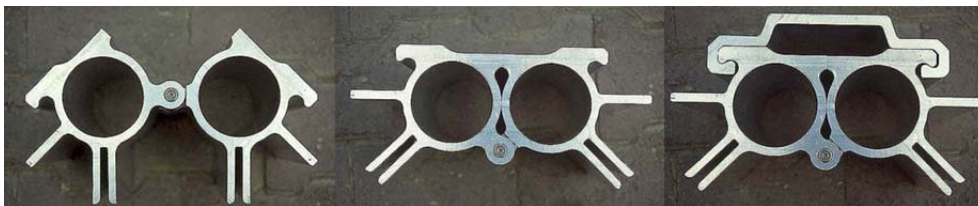
Fig. 18: Il nodo-macchina progettato dal Grupo Estran per il Padiglione del Venezuela all'Expo di Siviglia.
